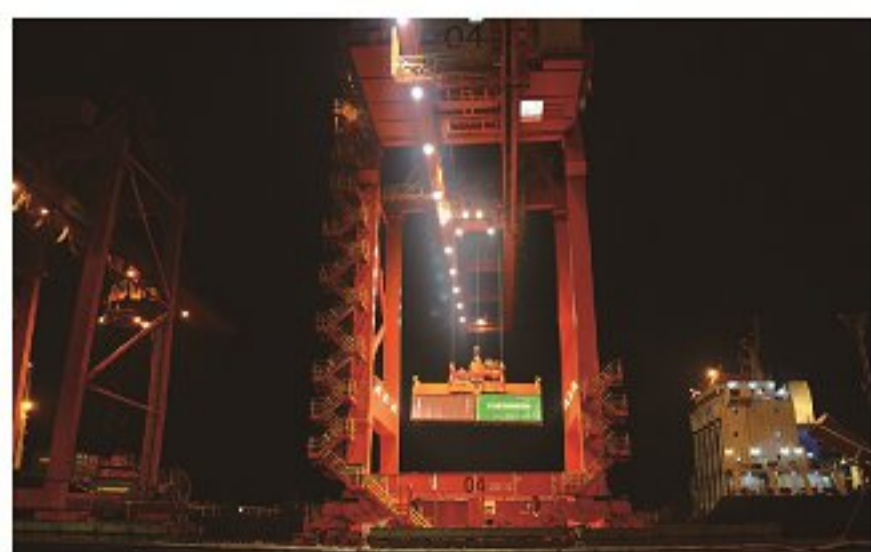
《4#桥吊》 林 咏 操作部
