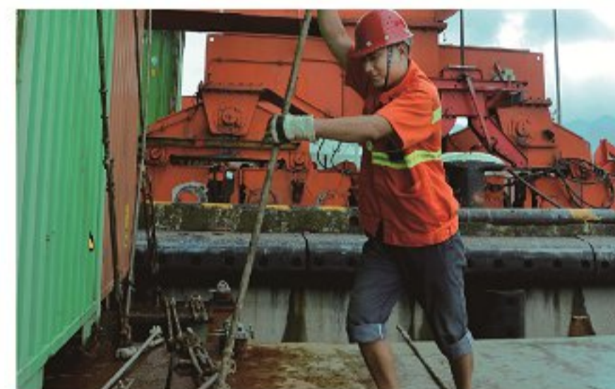
《加固作业》 江卫民 操作部
